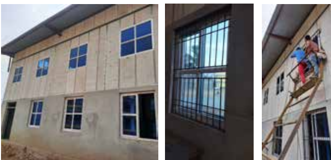
第四段階体育館建設状況：窓工事
