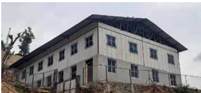
第四段階体育館建設状況：窓工事完了状況
